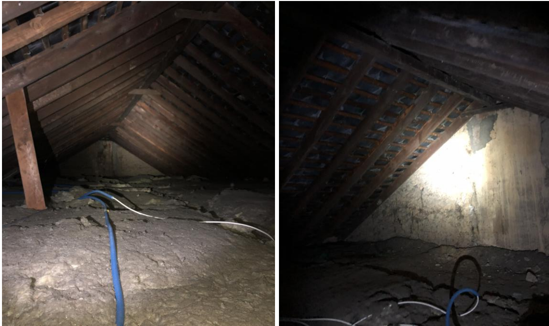
Figure 15 : combles du 80 rue de Lorient - Iao senn 2023
