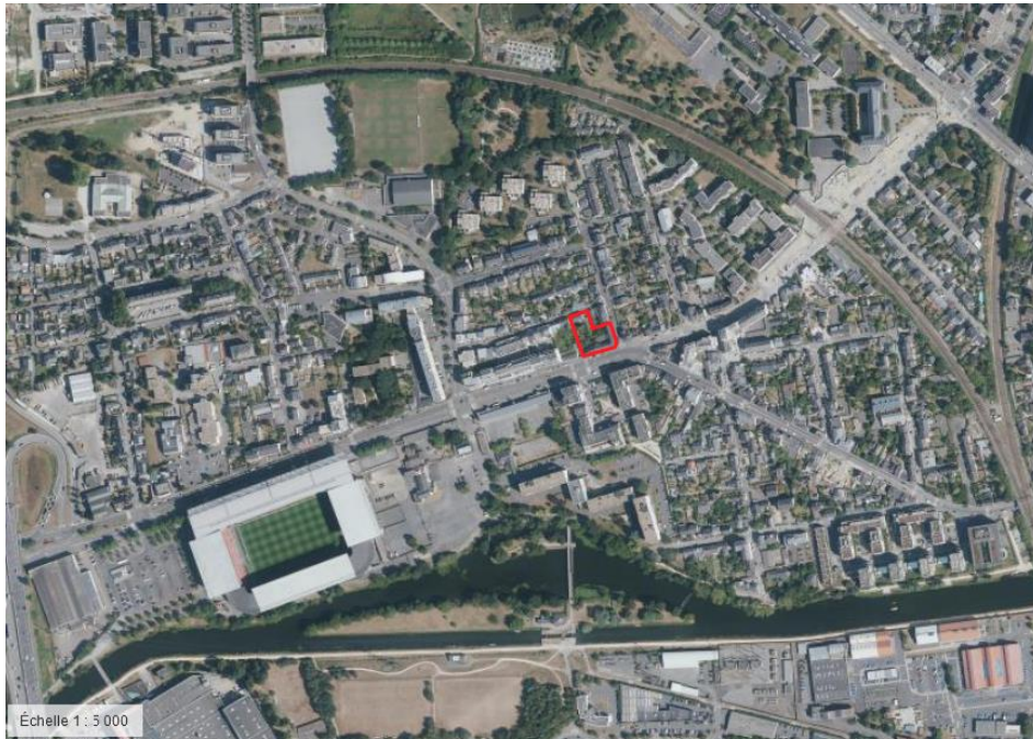
Figure 12 : Étendue de l'aire d'études à l'échelle du quartier de la route de Lorient - Géoportail 2023
